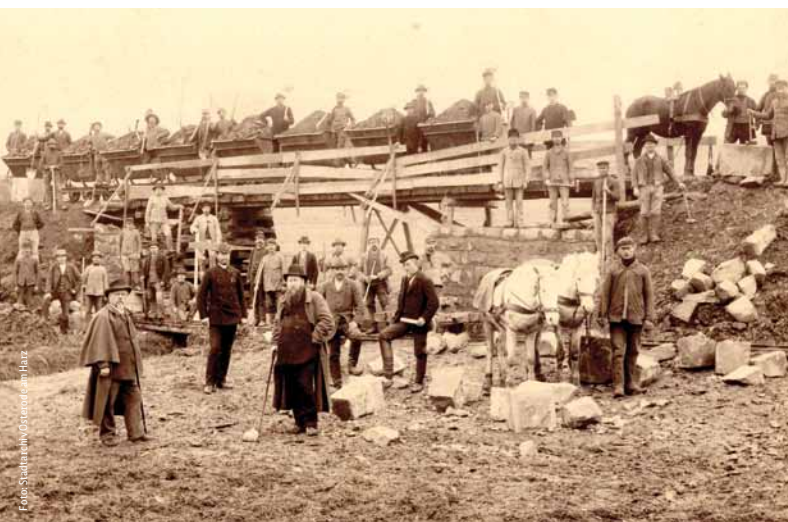
Bau der Bremke Brücke etwa einen Kilometer vor dem Bahnhof Osterode.
